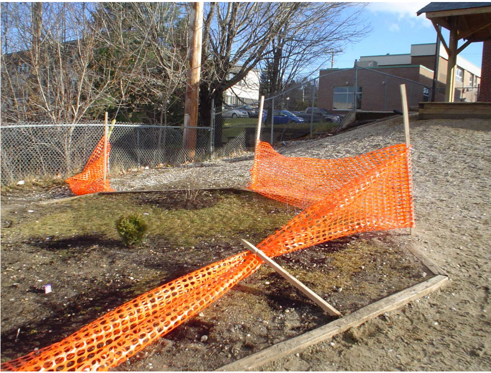
L'enclos situé du côté est : on voit que certains poteaux ont été carrément arrachés du sol et que la clôture est en piteux état.
